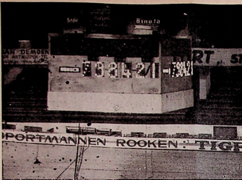
Fig. 1. - Deze foto toont ons duidelijk de schikking van de luidsprekers boven op de beroemde «lichtbak» van het Sportpaleis. In totaal werden vier luidsprekers opgesteld, die ieder een hoek van 45° bestrijken. Dank zij hun richteffect schakelen zij alle schadelijke nagalmen weergalminvloeden uit.
